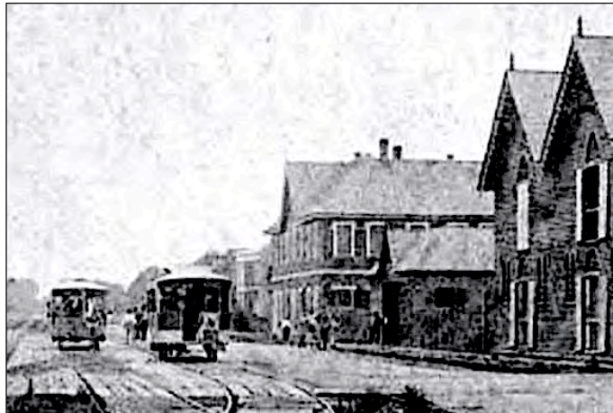
Dépôt de la ligne du streetcar, rue St. Charles en 1860. (nolahistoryguy.com).
